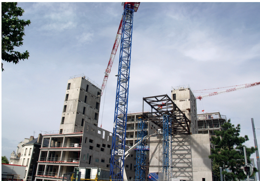
Immeubles en construction © epures
