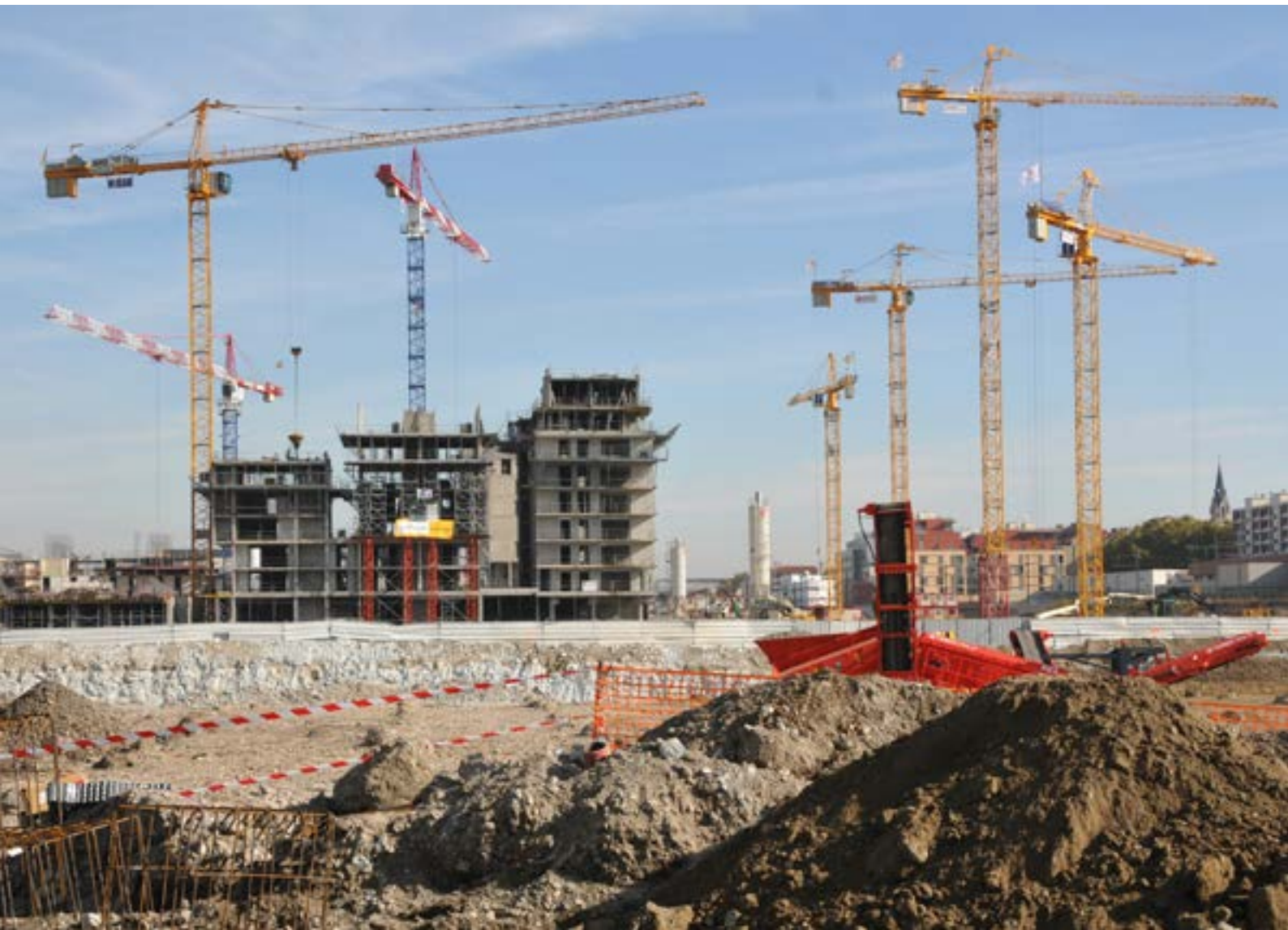
Chantier du confluent, Lyon 2 e
