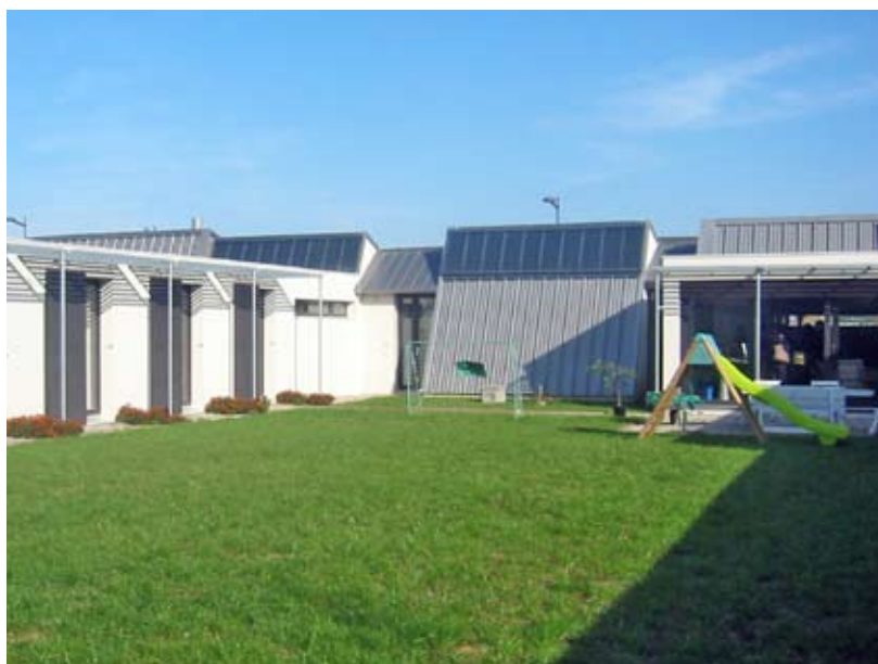
Un espace « ouvert » pour chaque logement, Résidence Les Hauts de Feuilly, Saint-Priest
