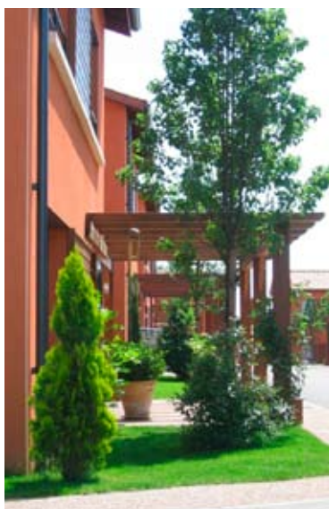
Traitement paysager de qualité, Lotissement des Garennes, Lyon 5
