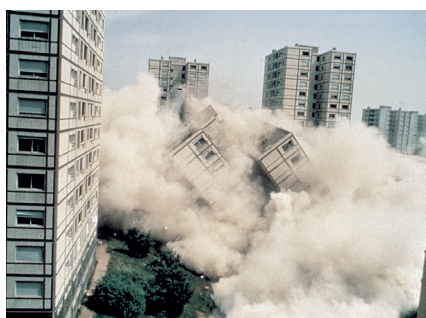
Destruction des premières tours aux Minguettes, 1983
